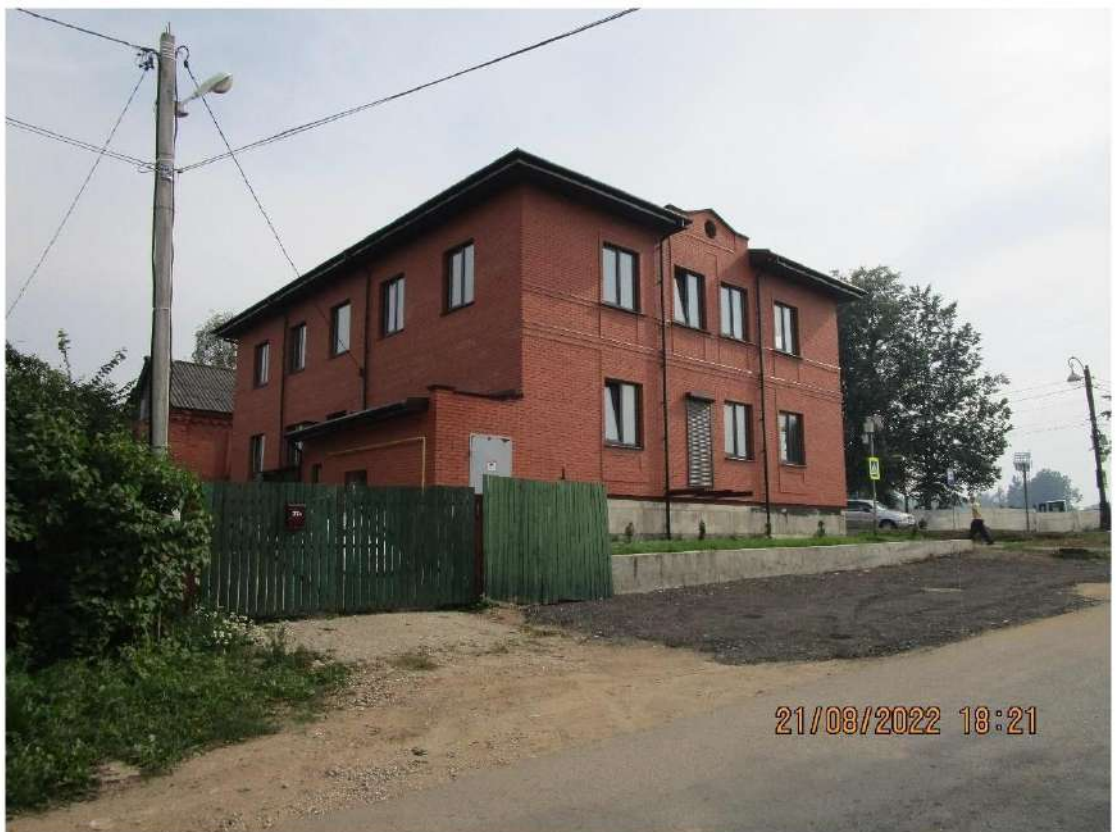
Рисунок 4 – Фотофиксация существующего состояния территории
