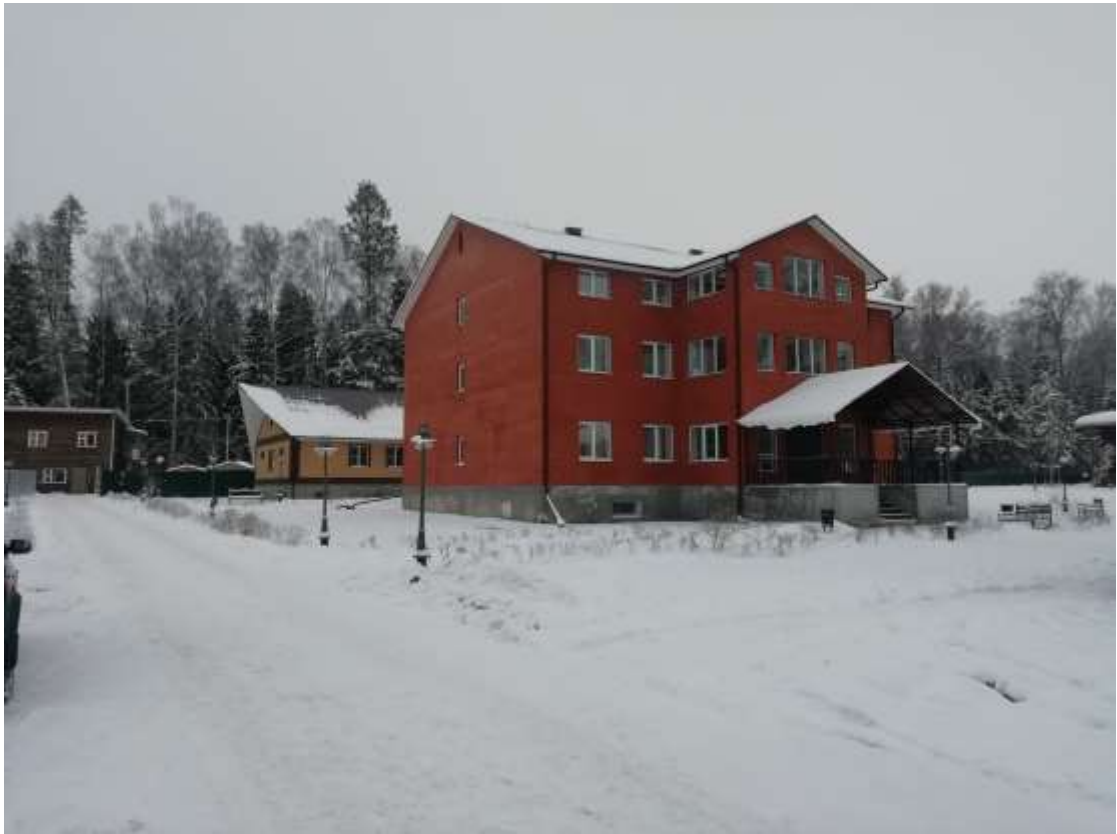
Рисунок 4 – Фотофиксация существующего состояния территории. Вид 1
