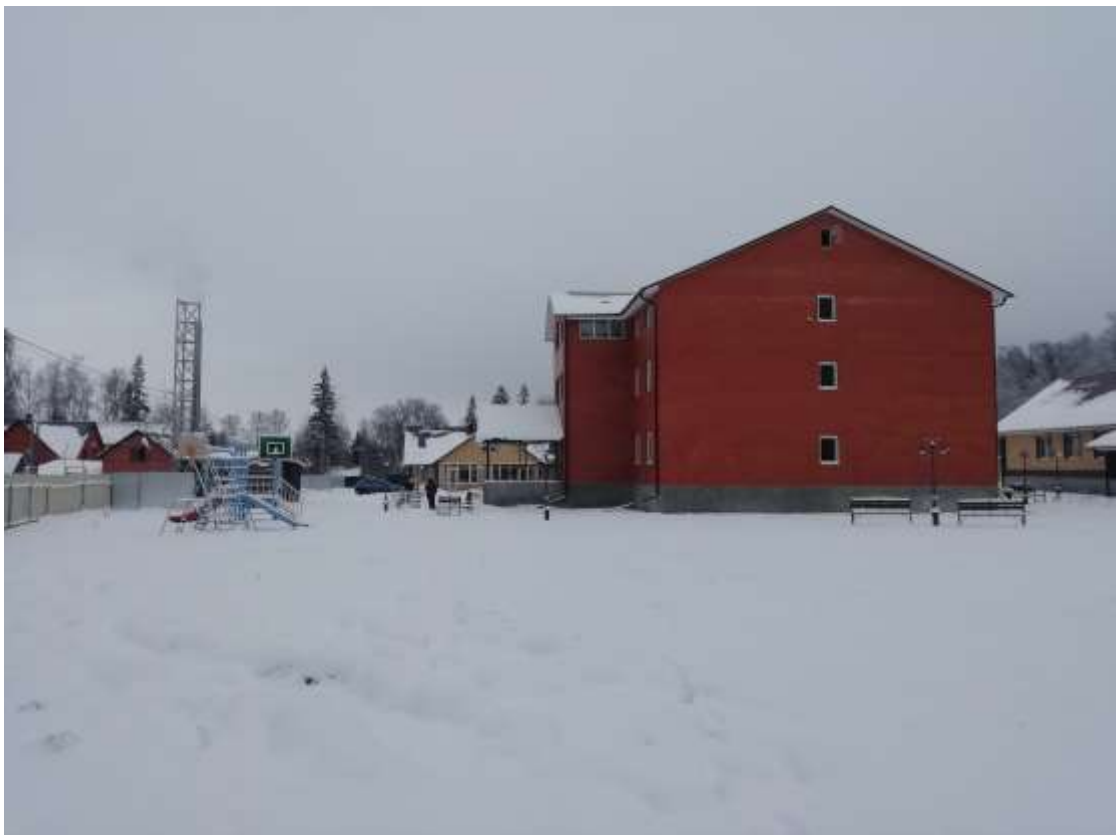
Рисунок 5 – Фотофиксация существующего состояния территории. Вид 2
