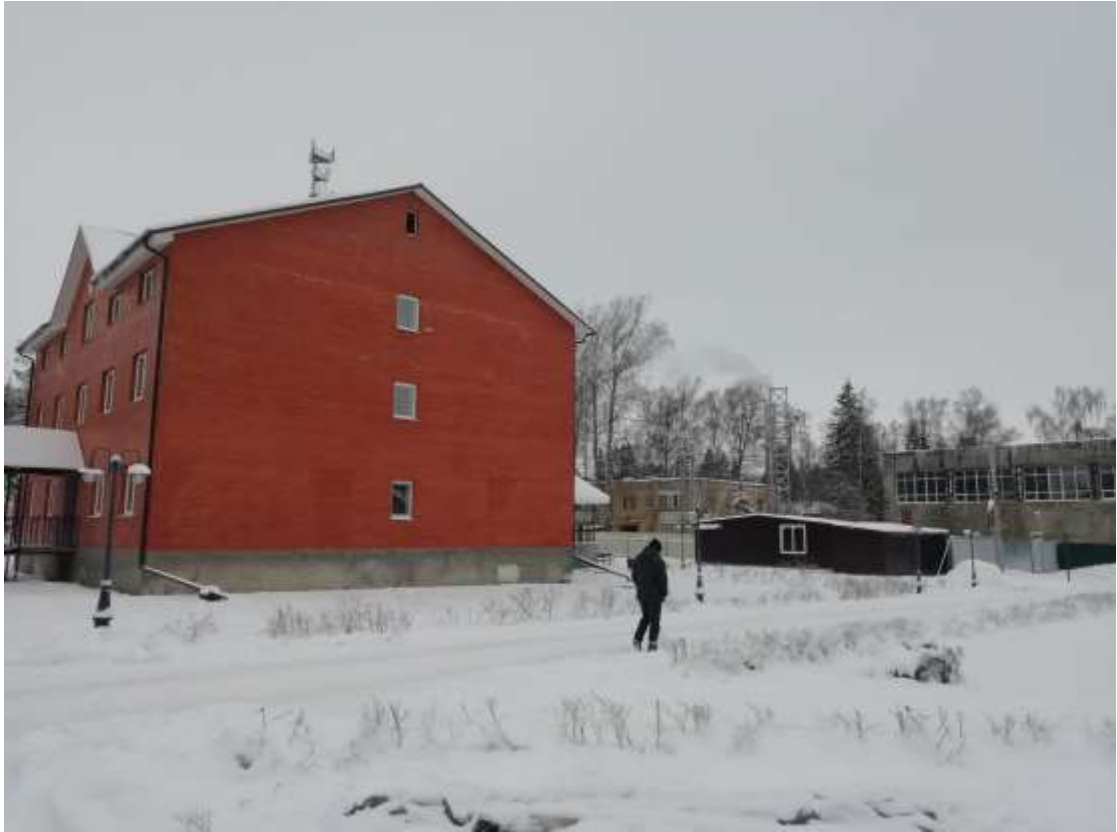
Рисунок 6 – Фотофиксация существующего состояния территории. Вид 3
