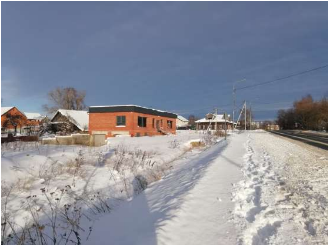
Рисунок 6 – Фотофиксация существующего состояния территории. Вид 3
