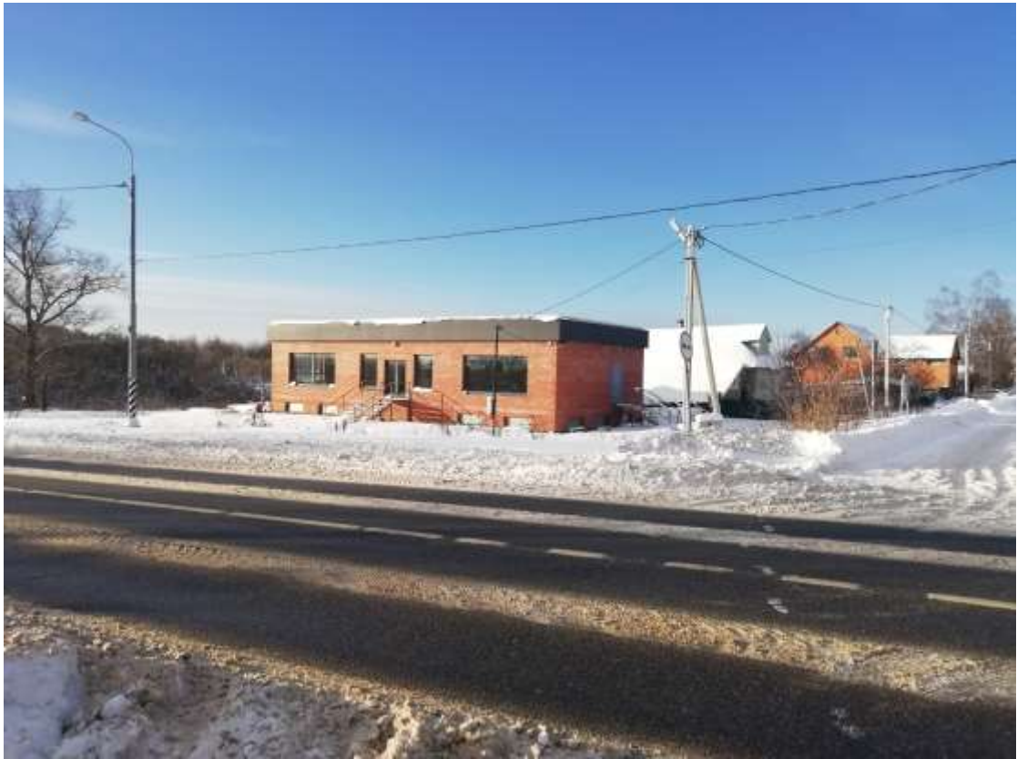
Рисунок 4 – Фотофиксация существующего состояния территории. Вид 1
