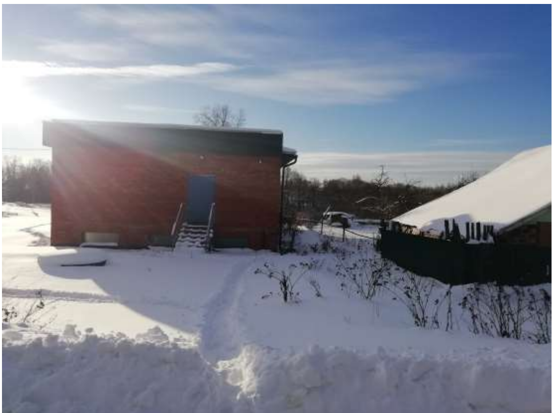
Рисунок 7 – Фотофиксация существующего состояния территории. Вид 4
