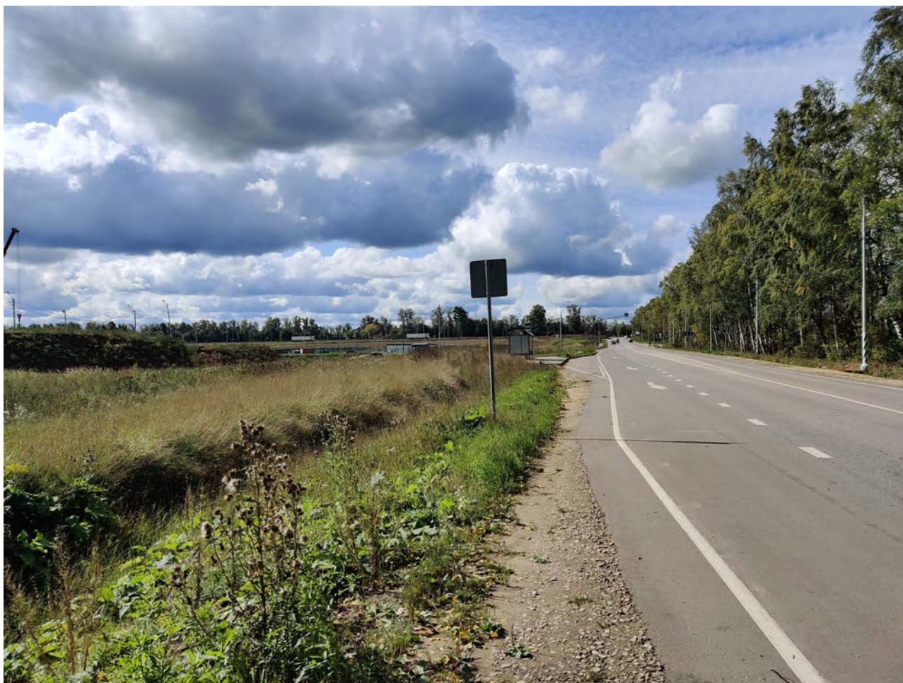
Рисунок 4 – Фотофиксация существующего состояния территории
