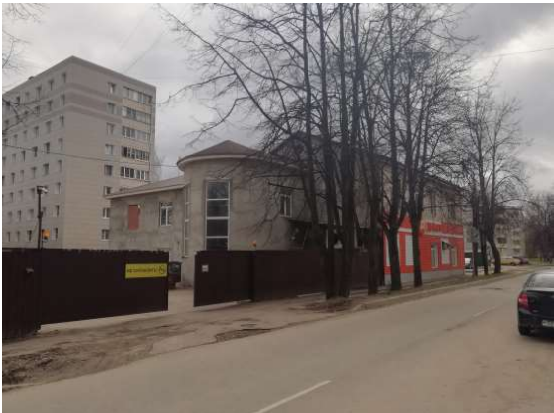
Рисунок 5 – Фотофиксация существующего состояния территории. Вид 2
