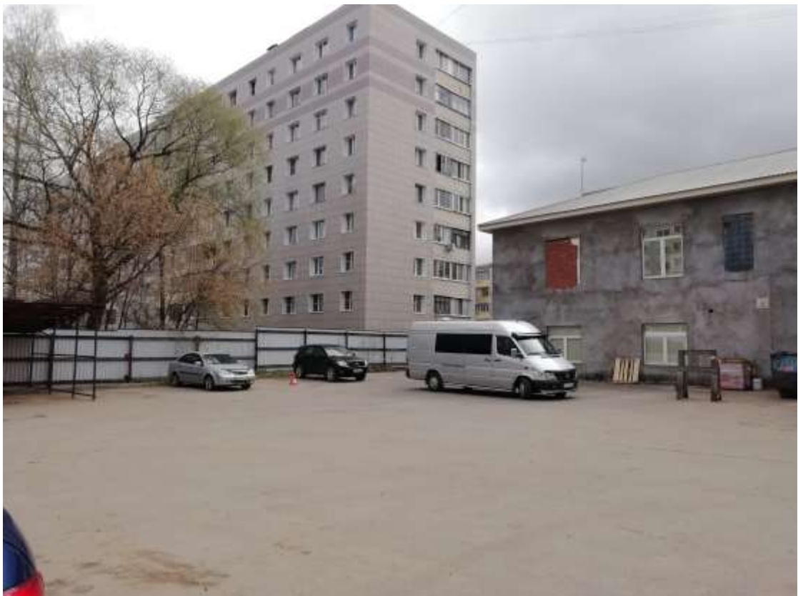
Рисунок 7 – Фотофиксация существующего состояния территории. Вид 4
