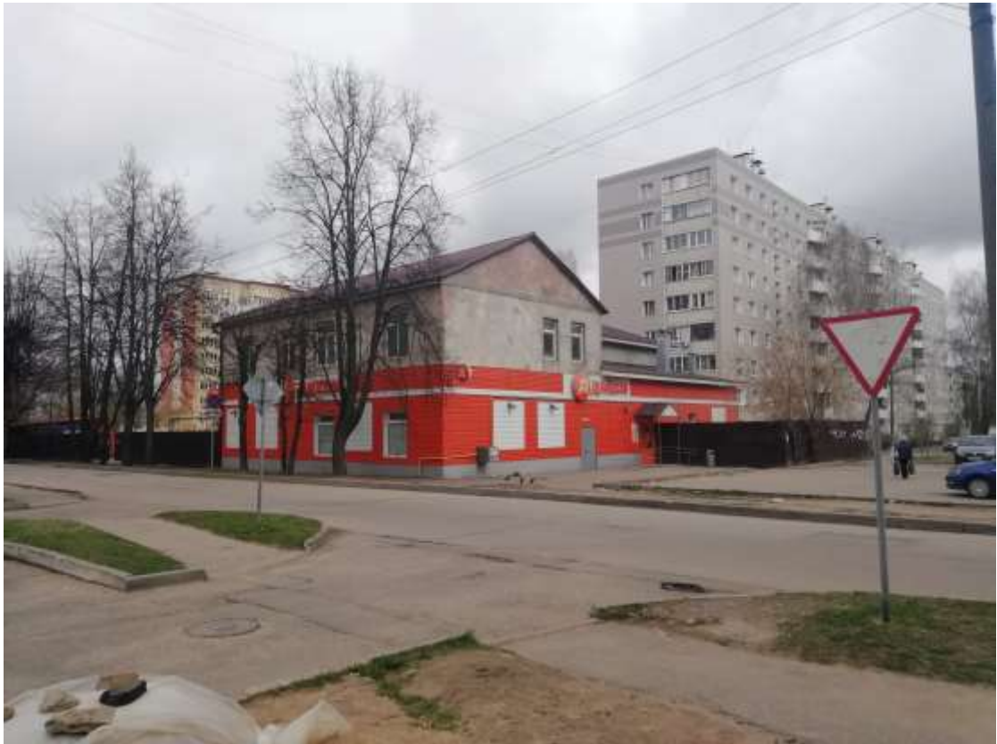
Рисунок 4 – Фотофиксация существующего состояния территории. Вид 1
