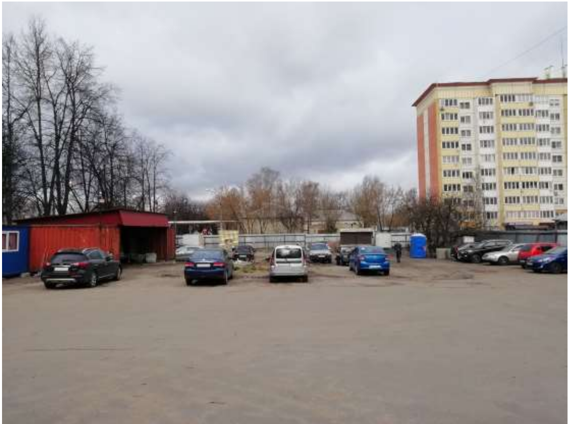
Рисунок 6 – Фотофиксация существующего состояния территории. Вид 3
